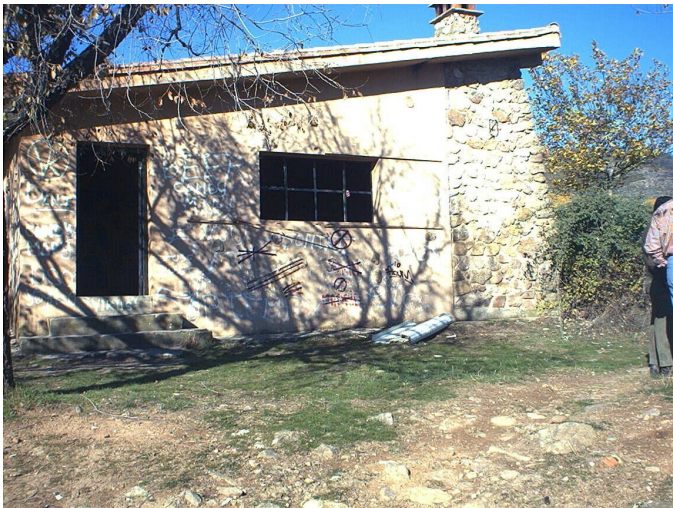
Refugio de pescadores de Madrigal de la Vera, antes de su rehabilitación a refugio abierto.
