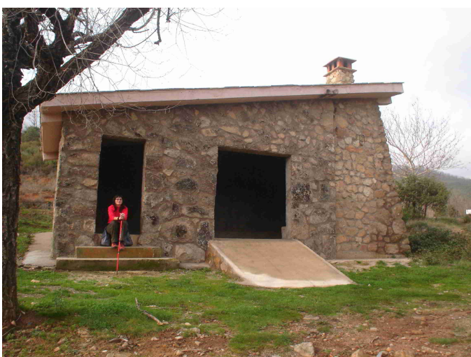
Refugio de pescadores de Madrigal de la Vera tras la rehabilitación.
