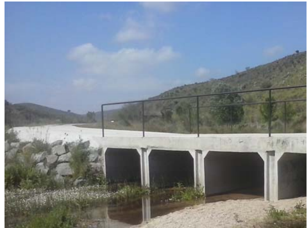
Escollera colonizada por la vegetación
