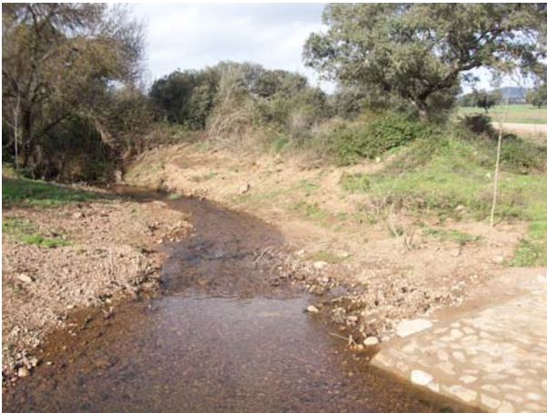
Taludes tendidos o suavizados, aguas abajo del drenaje
