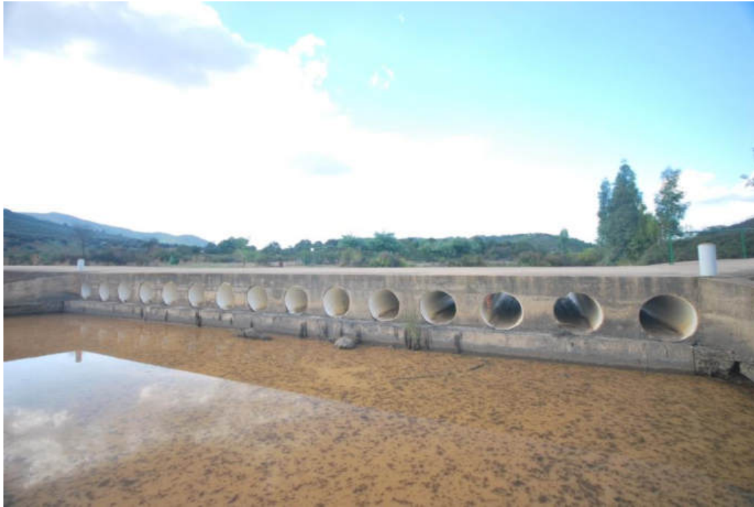
Badén de tubos
