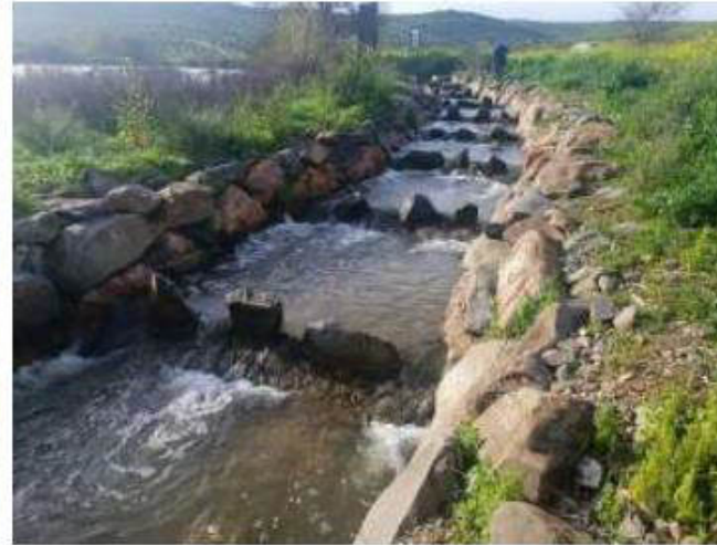
Fotos de antes de la limpieza del río artificial para el paso de peces del río Matachel (Id. 17)
