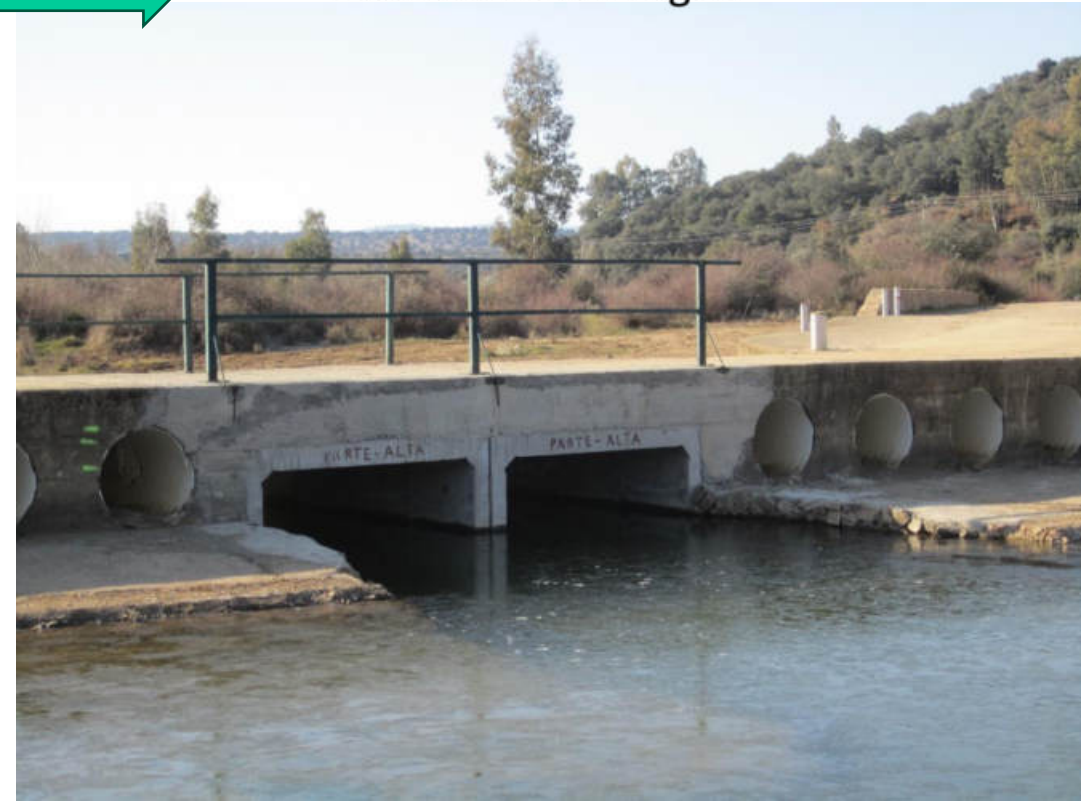
Marcos de hormigón
