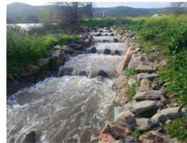
Fotos de después de la limpieza del río artificial para el paso de peces del río Matachel (Id. 17)
