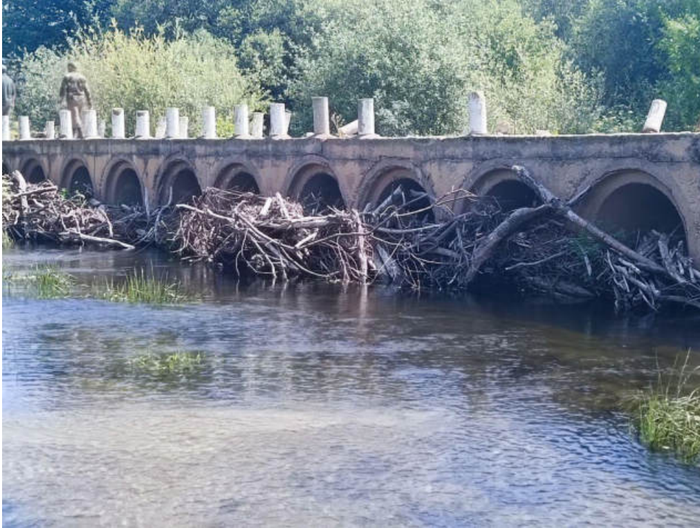
Fotos antes y después de la limpieza en el badén de tubos de Garganta Cuartos (Id. 18)
